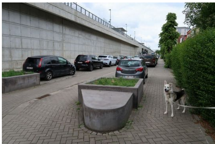
Talus du chemin de fer - rue Hoorickx
