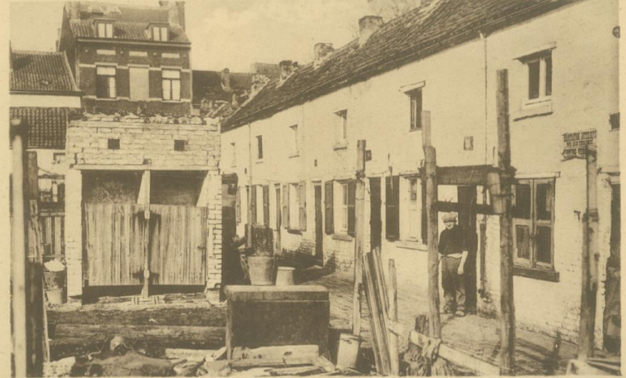
1. Taudis démolis à Anderlecht — Afgebroken krotten te Anderlecht
