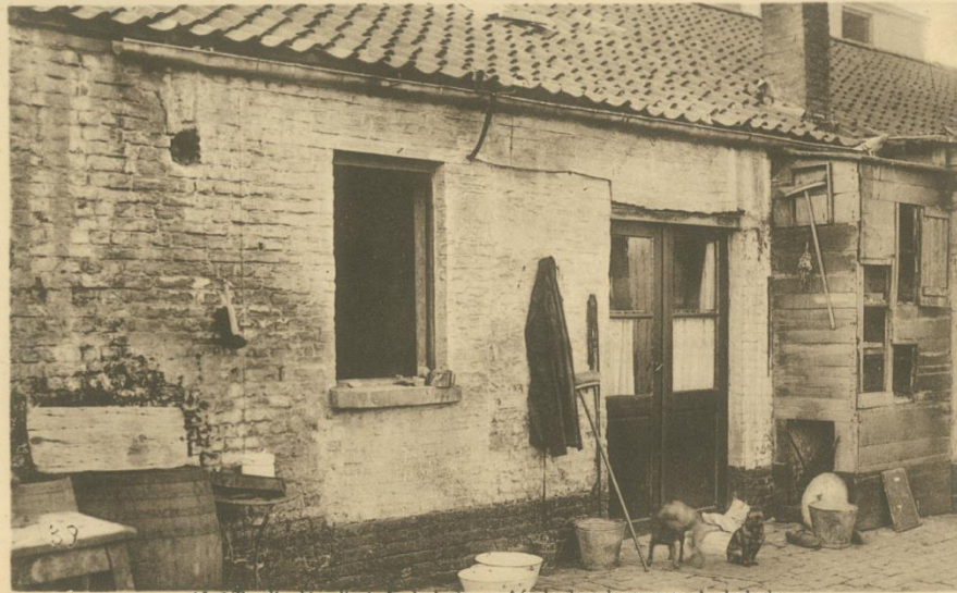
15. Taudis démolis à Anderlecht — Afgebroken krotten te Anderlecht
