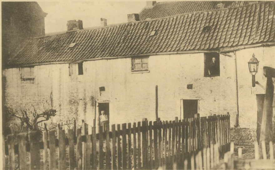
2. Taudis démolis à Anderlecht — Afgebroken krotten te Anderlecht
