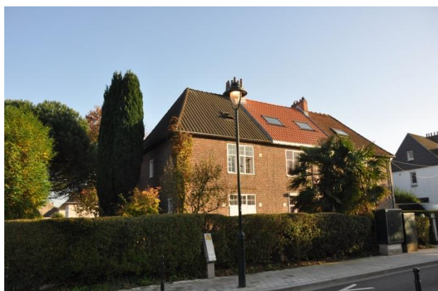
ill. 14 : arbre de hauteur inadapté
